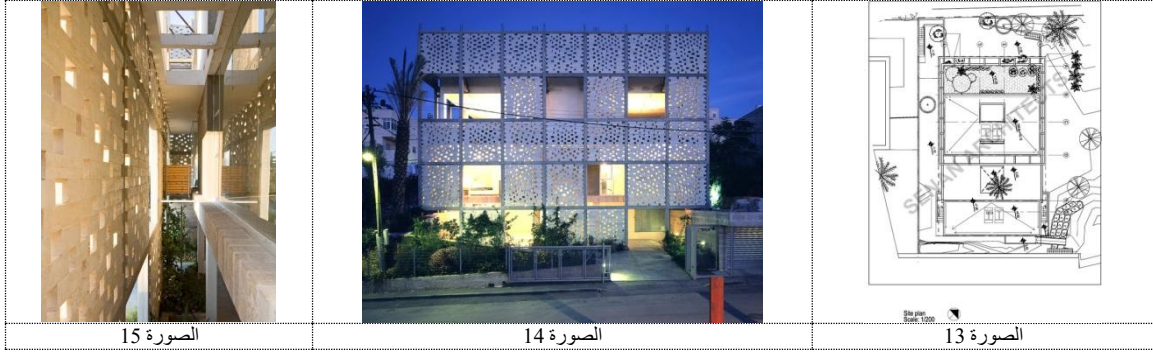
الصورة 13: (يمين) توضح الموقع العام والحوش (Land Landscape). الصورة 14: (وسط) الواجهة الشمالية لبيت المشربية الخاصة بالمنزل ومواد غلاف المبنى من الحجر الصورة 15: (يسار) توضح فجوة المتر الواحد بين الكسوة الخارجية للمشربية وتلك الداخلية المصدر: ( www.greatbuildings.com/buildings/L_Institut_du_Monde_Arabe.html )
